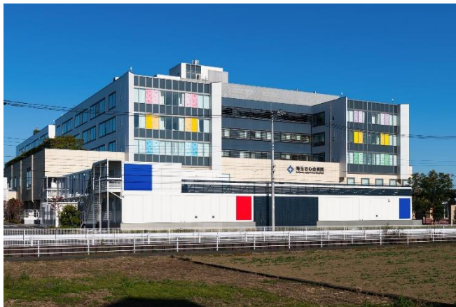
仮設病棟 外観
