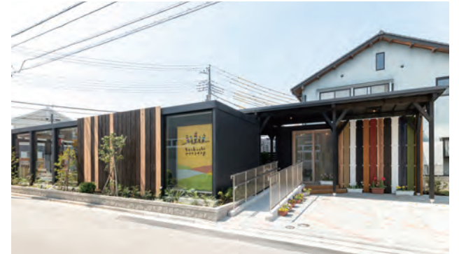
保育施設外観
