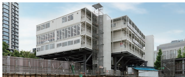
建設現場事務所
