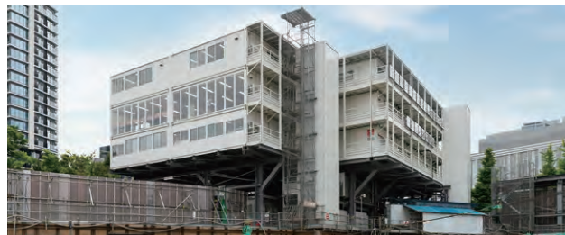
建設現場事務所
