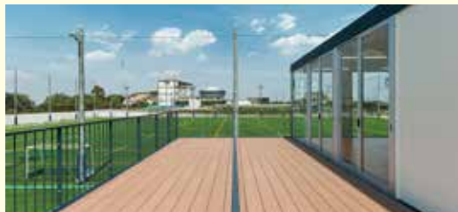
屋上エアデッキ
