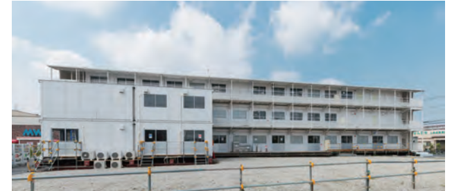
仮設レンタル物件
