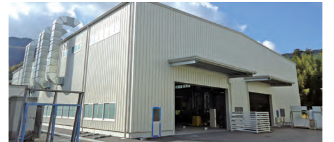
姫路工場外観
