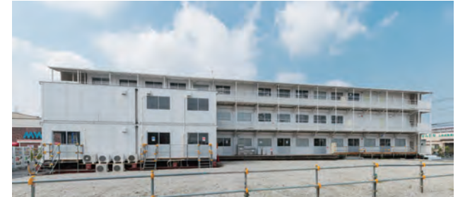
仮設レンタル物件
