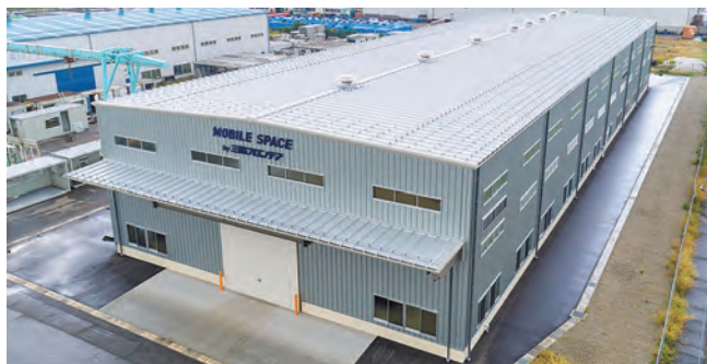
新潟工場・外観
