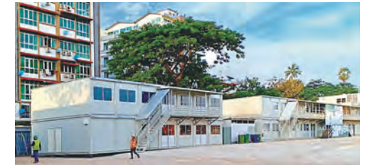
施工物件(ミャンマー)
