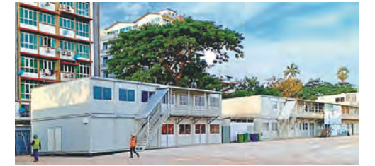
施工物件(ミャンマー)
