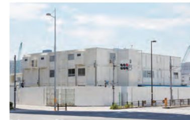
建設現場事務所
