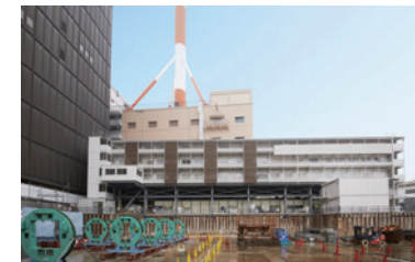
建設現場事務所(外観)
