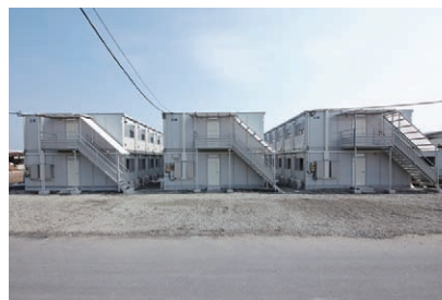
宮城県石巻市 宿泊施設
