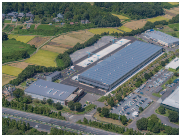
敷地空撮写真
