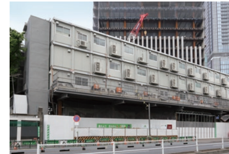
建設現場事務所
