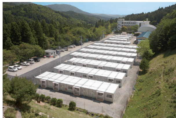
石巻市 旧大原中学校跡地に建設した応急仮設住宅
