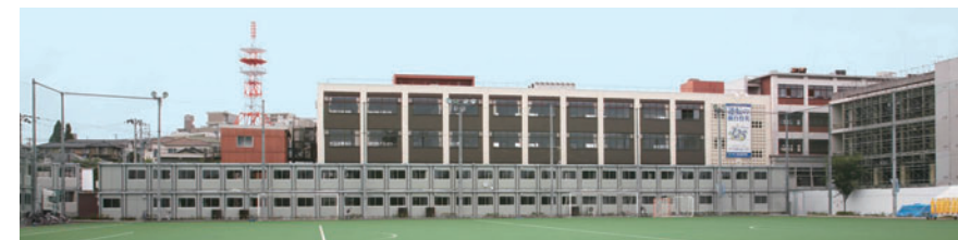
手前が仮設校舎、奥が本校舎
