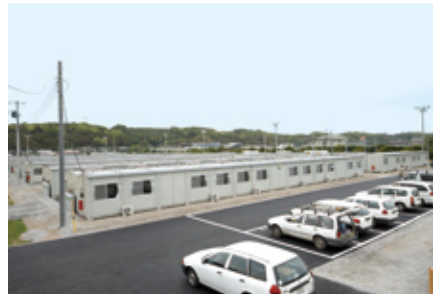
千葉県旭市横根地区の応急仮設住宅
