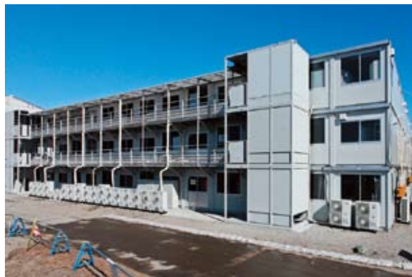
COSMO CT-J設置現場
