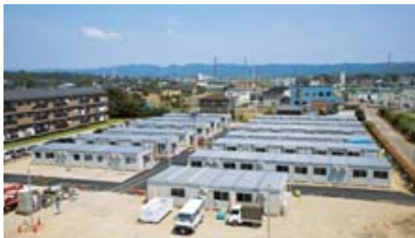
新潟県中越沖地震の応急仮設住宅
