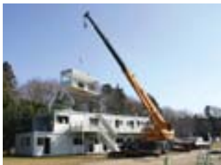
建設現場事務所 施工風景
