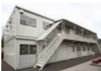
建設現場事務所
