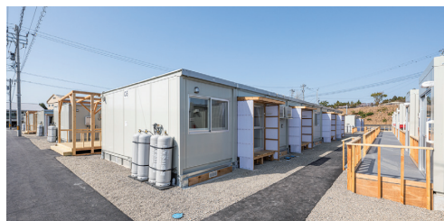
応急仮設住宅（穴水陸上競技場）
