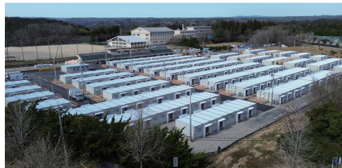
応急仮設住宅（穴水陸上競技場）
